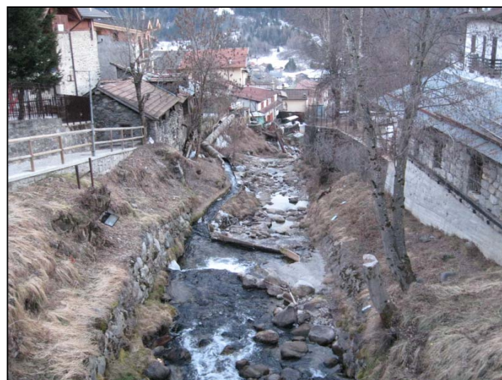
Fotografia 4 e 5 - Muri spondali alti o edifici adiacenti al torrente Fiumeclo, esistenti tra Via Molina e Via Vittorio Emanuele, che consentono di mantenere il deflusso liquido e il materiale solido trasportato all'interno dell'alveo.
