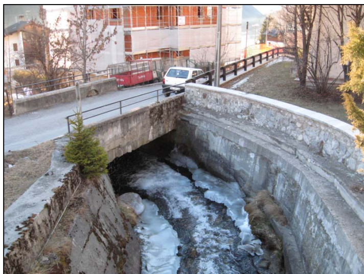
Fotografia 6 e 7 – Punti critici per possibile fuoriuscita di materiale liquido e solido rappresentati dal ponte stradale di Via Vittorio Emanuele e dal ponte carraio di accesso a delle case sul torrente Fiumeclo.
