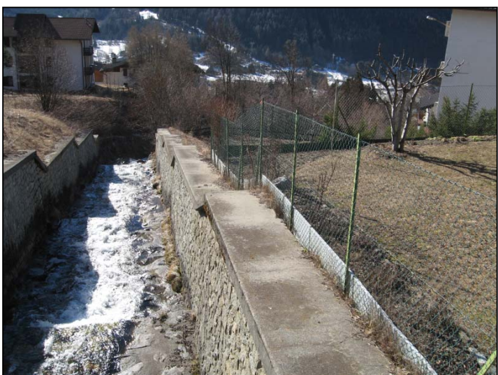
Fotografia 4 e 5 - Muri spondali alti o edifici adiacenti al torrente Fiumeclo, esistenti tra Via Molina e Via Vittorio Emanuele, che consentono di mantenere il deflusso liquido e il materiale solido trasportato all'interno dell'alveo.
