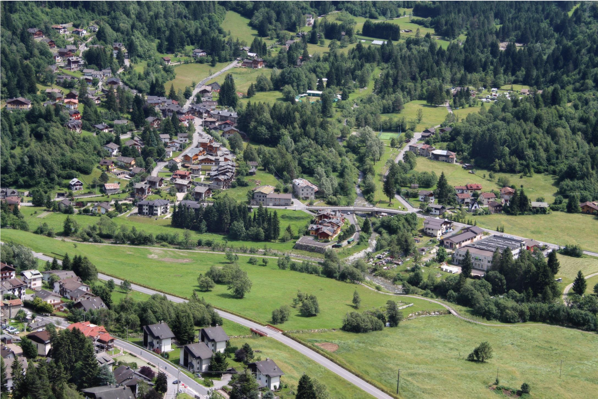
2.STATO DI FATTO_ Vista aerea del lotto dal versante nord
